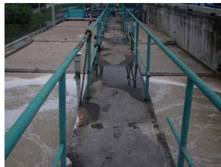
บ่อ Equalization tank
